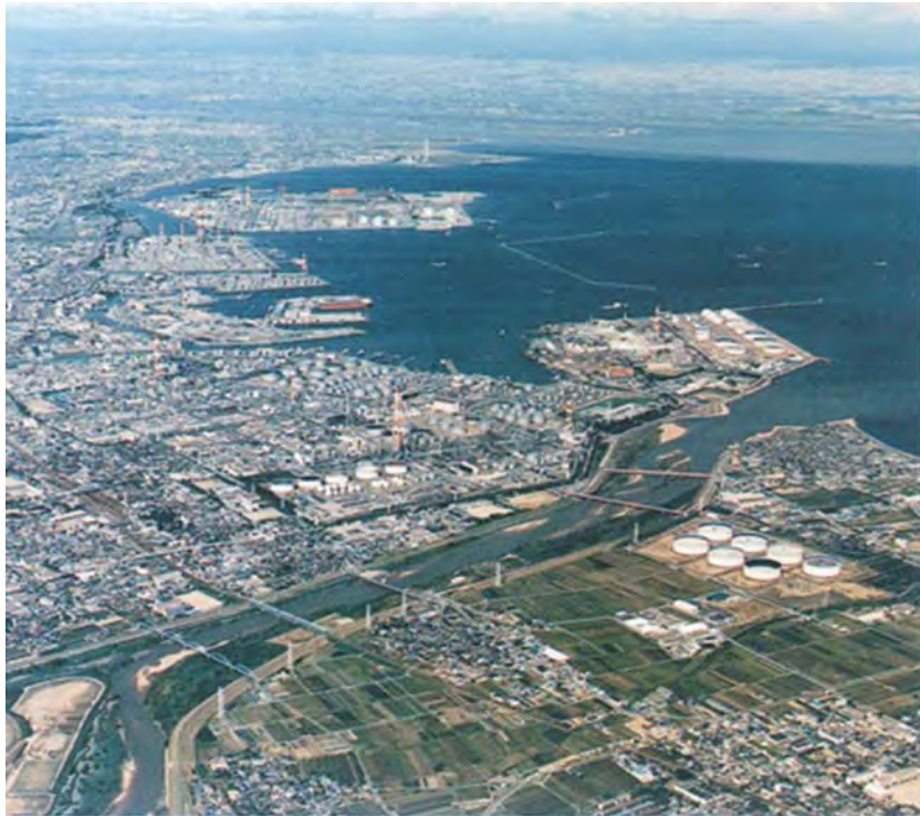
四日市石油化学コンビナートの全景 (1986年頃)
