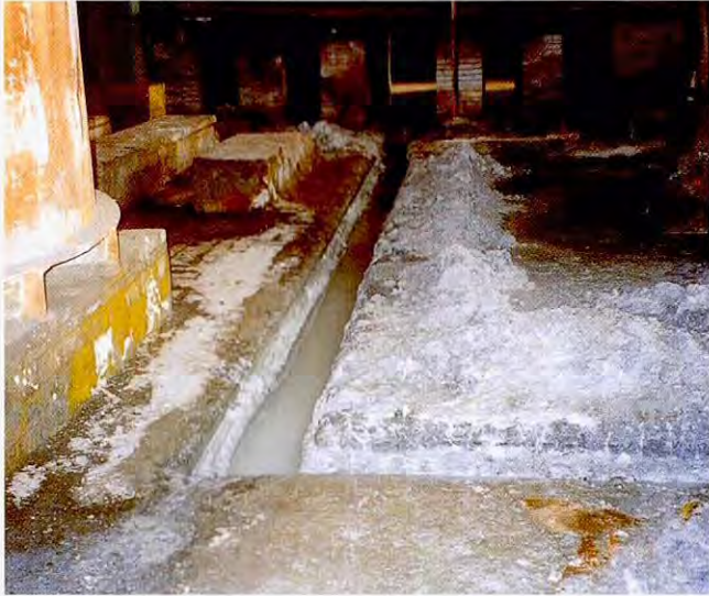
— 肥料工場内の廃水路 —
