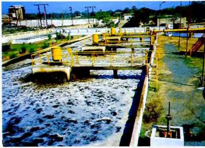
写真3 曝気槽
