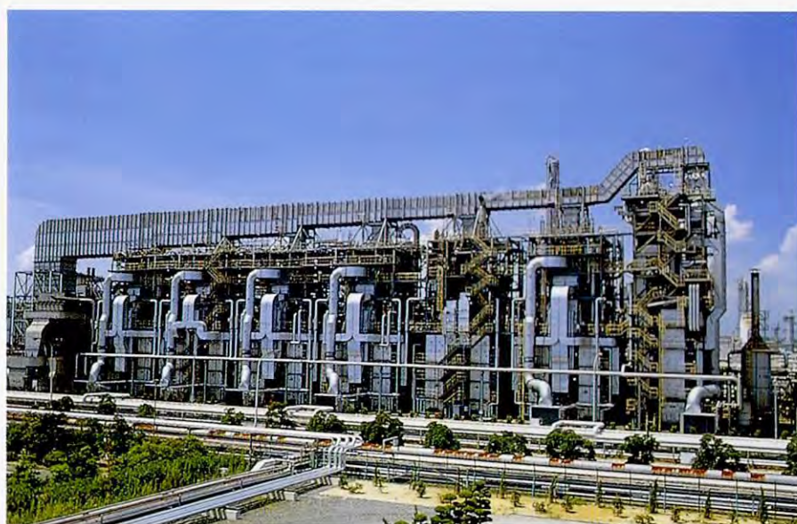
煙道の集合化 (ナフサ分解炉)
