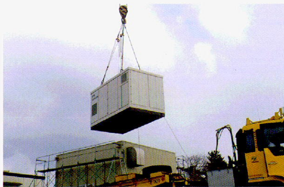
照片1: LPG重整催化的燃料电池
