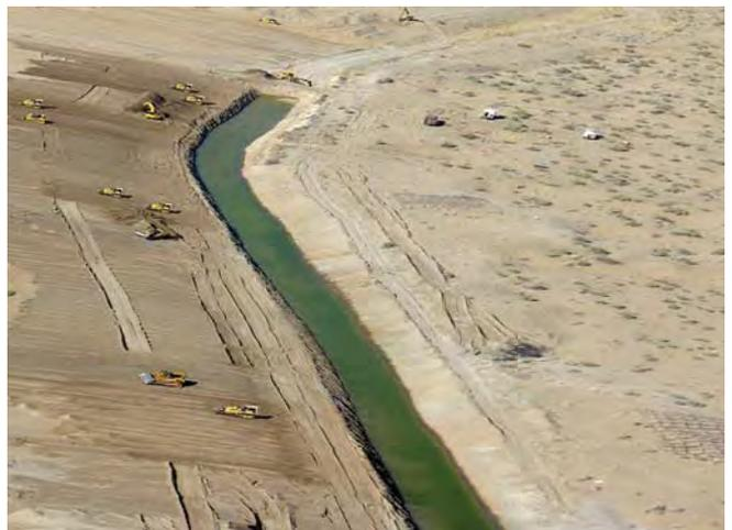
農業排水の再利用を目的とした集水のための運河。処理場につなげるべく、大規模な延長工事が続けられている。（トルクメニスタン研修員提供）
