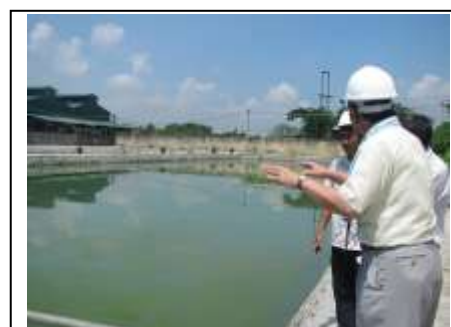
ここに活性汚泥処理設備を導入予定
