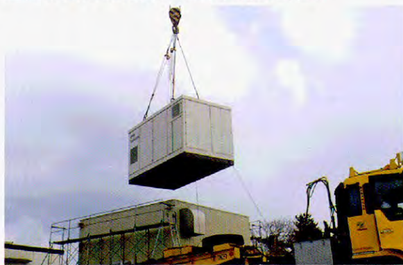
照片1: LPG重整催化的燃料电池
