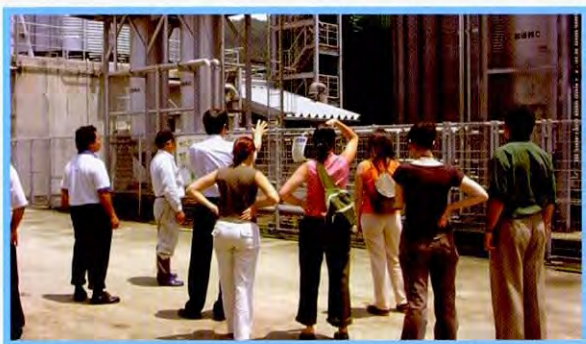
参观利用生物能源（Biomass）发电的设施
