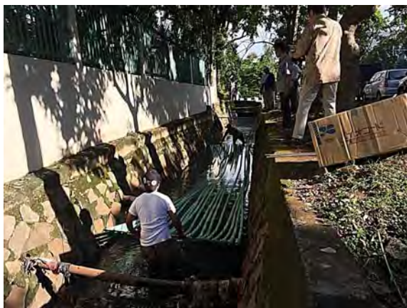
ジャカルタ市内の設置例 施工は 1 日で完成
