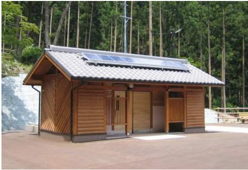
在公共廁所屋頂設置太陽能板
